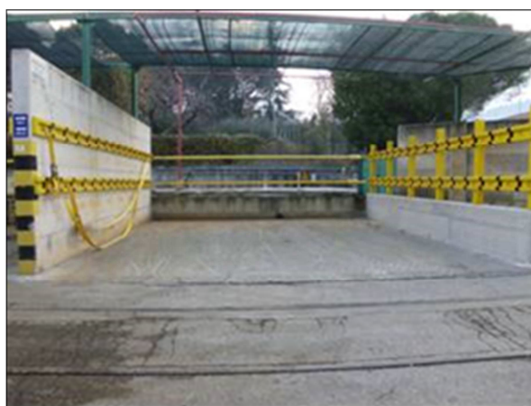
Figura 58: nuovi sistemi di ancoraggio dei fusti di fosforo giallo
