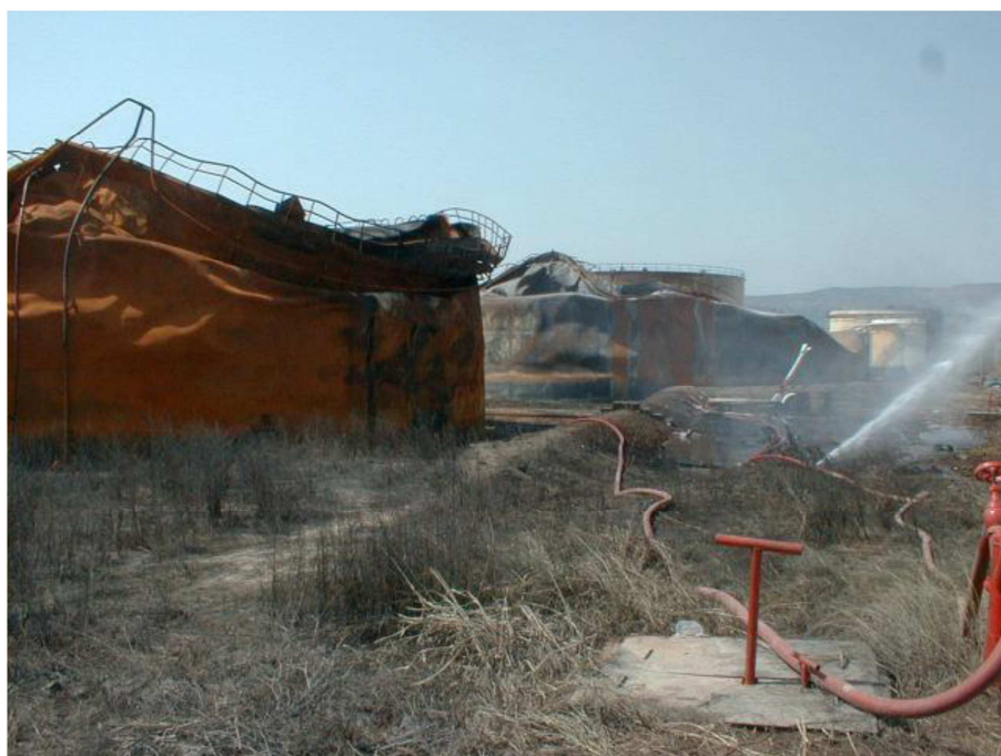
Figura 20: Terremoto di Izmit (Turchia), 1999, Mw=7.4: incendio e conseguente collasso di un serbatoio di stoccaggio nella raffineria di Yarimca; l'incendio ebbe gravissime conseguenze in termini di inquinamento atmosferico e problemi di approvvigionamento
