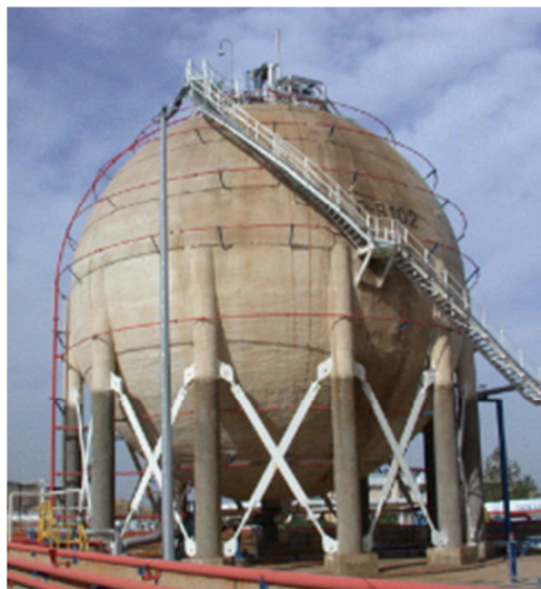
Figura 29 - Protezione sismica di serbatoi sferici realizzati col metodo Horton (supporto equatoriale su colonne): esempio di rinforzo con controventi rigidi
