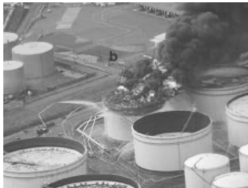
Figura 24 incendio interno al serbatoio prodotto dall'urto tetto-mantello (torch fire)
