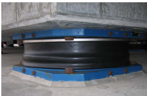
Figura 28 - Particolare di isolatore sismico
